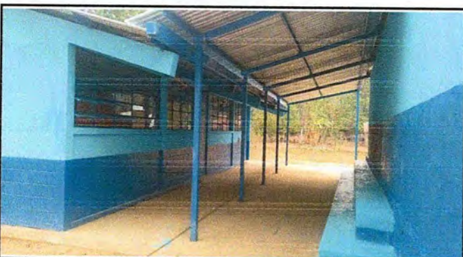
Foto 3: Aplicacion de pintura en exterior.
