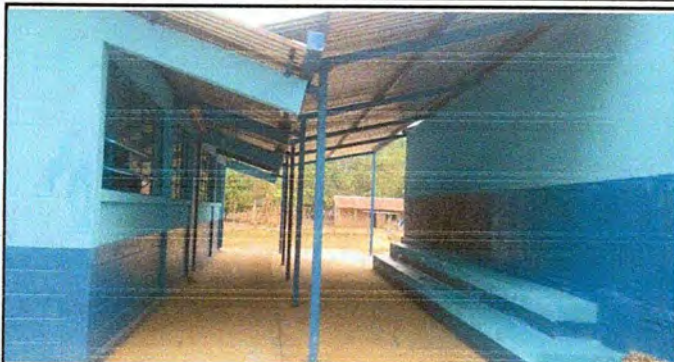
Foto1: Entechado del patio finalizado.
