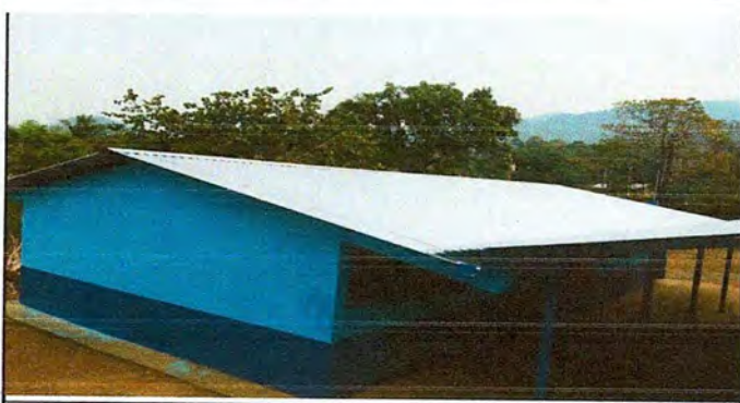
Foto 5: Entechado nuevo instalado en aula 1 y 2.
