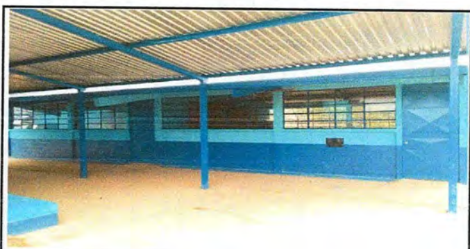
Foto 6: Entortado del patio finalizado.
