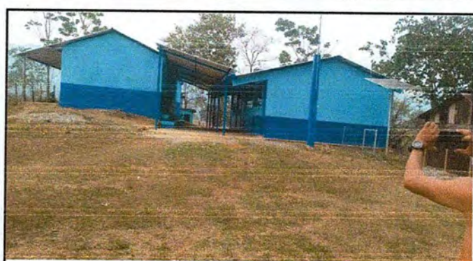
Foto 4: Aplicación de la pintura general.
